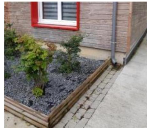
Déconnexion des gouttières, illustration non opposable
