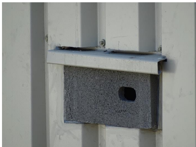
Nichoir en façade d'un bâtiment industriel
