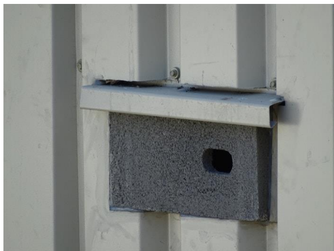
Nichoir en façade d'un bâtiment industriel
