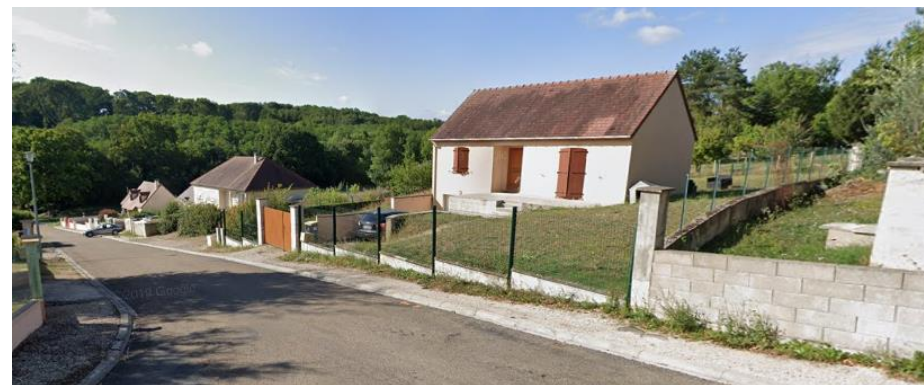
La rue des Pinsons, la zone est localisée derrière les constructions existantes
