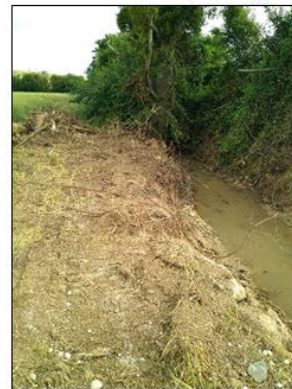
Fin de travaux
