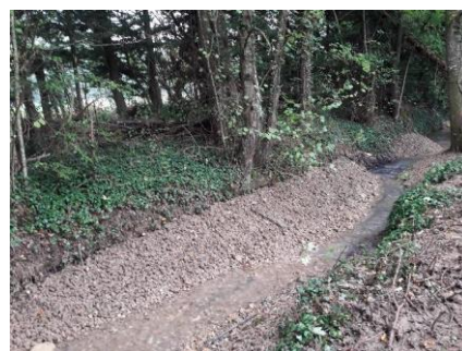
Recharge granulométrique au droit du parc de l'Orval
