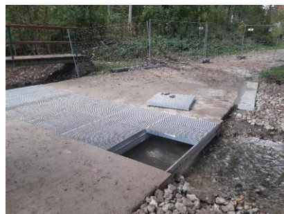
Aménagement au droit du gué des Bergeries
