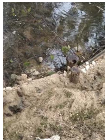
Vues après travaux
