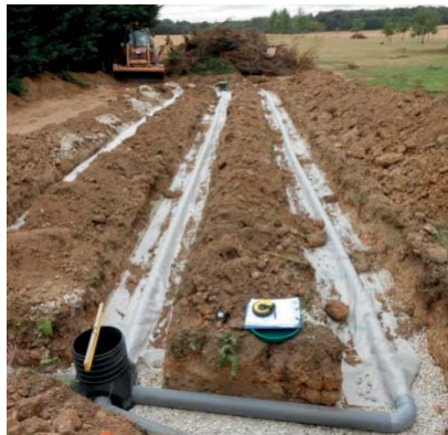
Réalisation d'une installation.
